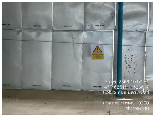
รูปที่ 23 ติดตั้งแผ่นกันเสียง Bloxteq ล้อมรอบอาคารชั้นที่กำลังก่อสร้าง (ปัจจุบันรื้อถอนเรียบร้อยแล้ว)
