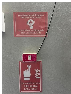
รูปที่ 68 จุดกดเพลิงไหม้ฉุกเฉิน
