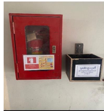
รูปที่ 60 ถังดับเพลิงและป้ายแนะนำวิธีการใช้งาน
