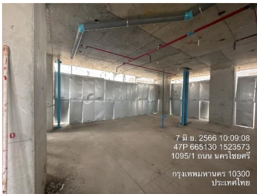
รูปที่ 23 ติดตั้งแผ่นกันเสียง Bloxteq ล้อมรอบอาคารชั้นที่กำลังก่อสร้าง (ปัจจุบันรื้อถอนเรียบร้อยแล้ว)
