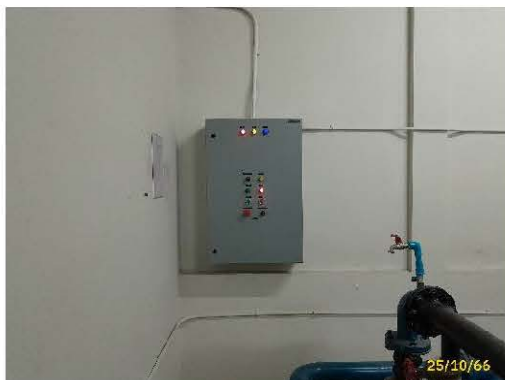
แผงควบคุมเครื่องสูบน้ำชั้นดาดฟ้า
