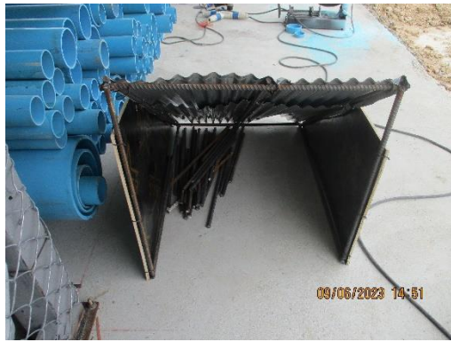
รูปที่ 59 ที่กำบังสะเก็ดไฟ
