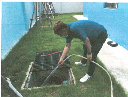
รูปภาพที่ 2.48 การขุดลอกตะกอนในรางระบายน้ำ
