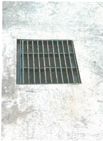
รูปภาพที่ 2.45 ตะแกรงครอบรูท่อระบายน้ำ
