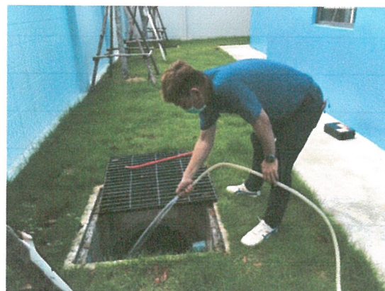
รูปภาพที่ 2.48 การขุดลอกตะกอนในรางระบายน้ำ
