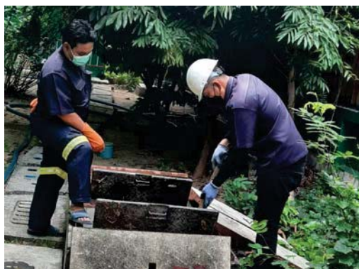
ทำความสะอาดบ่อกักน้ำ (Manhole)
