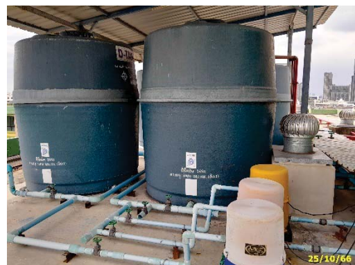
เครื่องสูบน้ำ และถังสำรองน้ำอุปโภค-บริโภคชั้นดาดฟ้า
