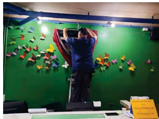
ดูแลตรวจสอบเครื่องปรับอากาศ/ระบายอากาศ และทำ การนำแผ่นกรองไปล้างทำความสะอาด
