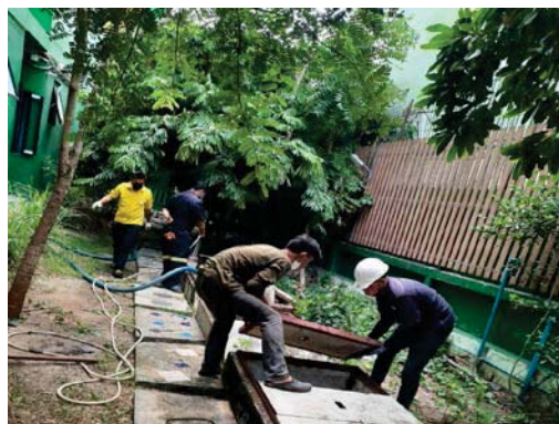
สำนักงานเขตเข้ามาสูบล้างสิ่งปฏิกูลจากระบบบำบัด
