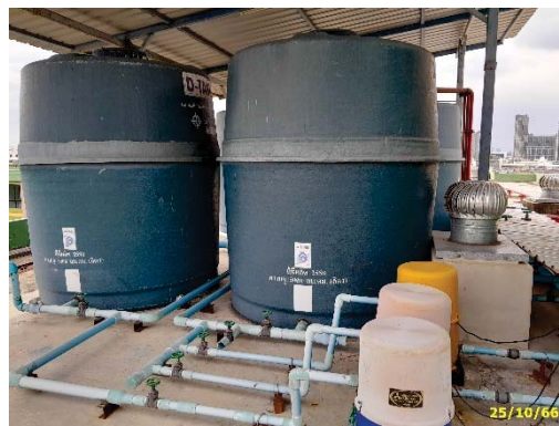
เครื่องสูบน้ำ และถังสำรองน้ำอุปโภค-บริโภคชั้นดาดฟ้า
