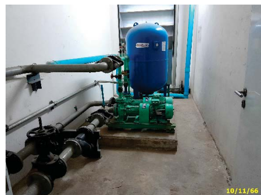
Booster Pump ชั้นดาดฟ้า
