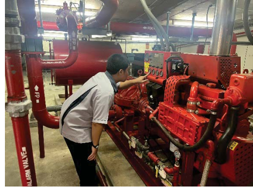
ดูแลตรวจสอบเครื่องสูบน้ำดับเพลิง
