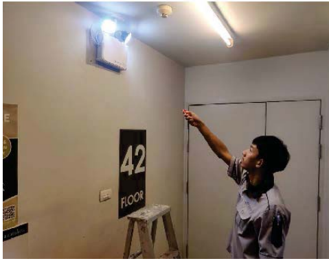
ดูแลตรวจสอบระบบไฟฉุกเฉิน
