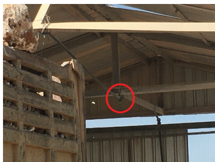
รูปที่ 2-23: ระบบสเปรย์น้ำโรงโม่
