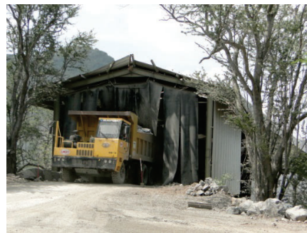
รูปที่ 2-4: การปิดคลุมย้งรับแร่
