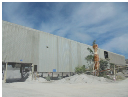
รูปที่ 2-3: การปิดคลุมโรงโม่หิน
