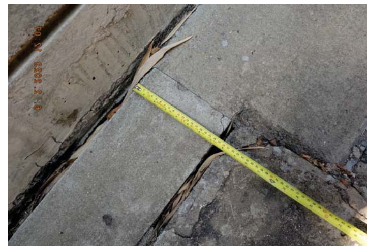
จุดที่ 10 ภาพที่ 62-66 รอยต่อพื้นที่กับผนังตลอดแนว
