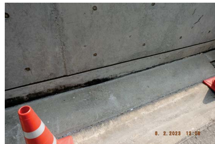
จุดที่ 10 ภาพที่ 62-66 รอยต่อพื้นที่กับผนังตลอดแนว
