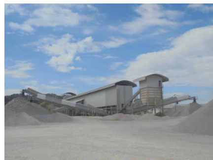
รูปที่ 2-23: การปิดคลุมอาคารโรงโม่หิน
