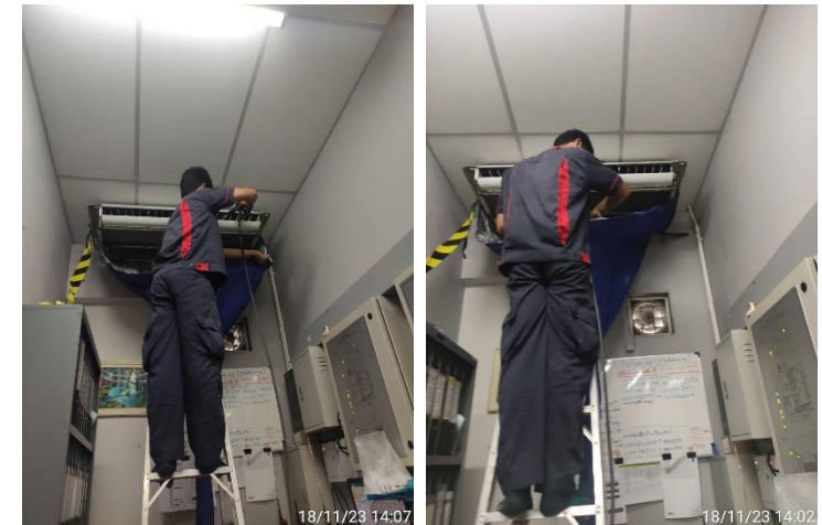
รูปที่ 3-29 ช่างอาคารทำความสะอาดเครื่องปรับอากาศส่วนกลาง
