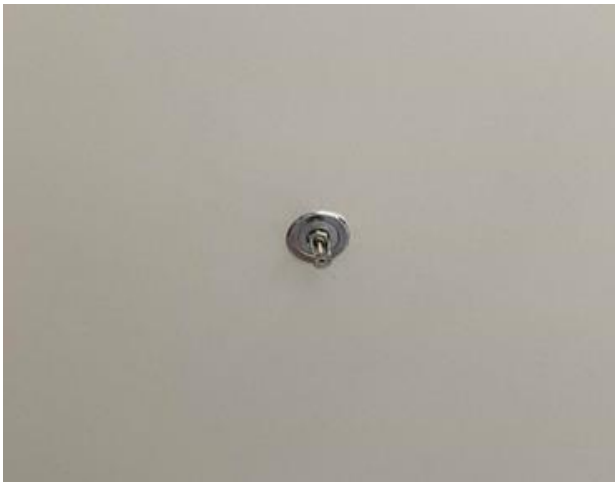
รูปที่ 3-33 หัวกระจายน้ำดับเพลิง (Sprinkler)
