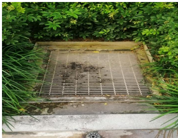
รูปที่ 3-23 ตะแกรงดักมูลฝอยที่บ่อพักน้ำสุดท้าย
