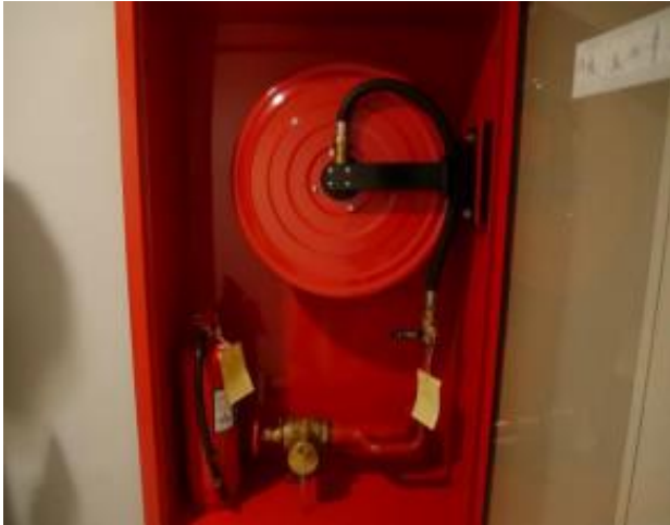
รูปที่ 3-30 ตู้เก็บสายฉีดน้ำดับเพลิง (Fire House)
