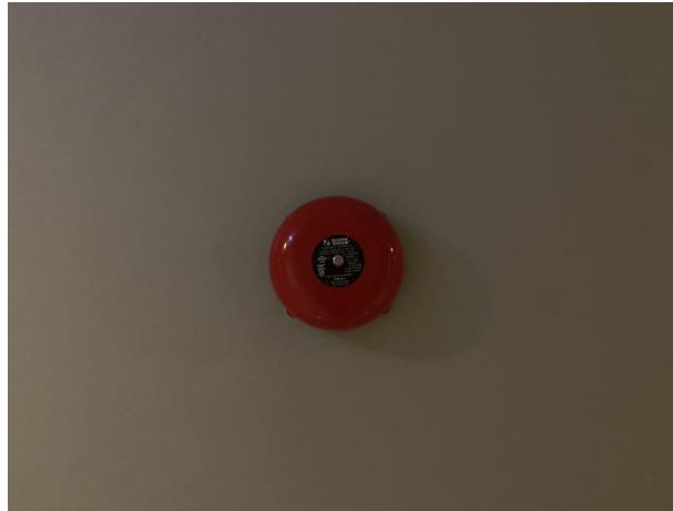
รูปที่ 3-43 กระดิ่งเตือนภัย (Fire Alarm Bell)
