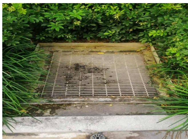
รูปที่ 2.4-5 บ่อพักน้ำภายในโครงการ
