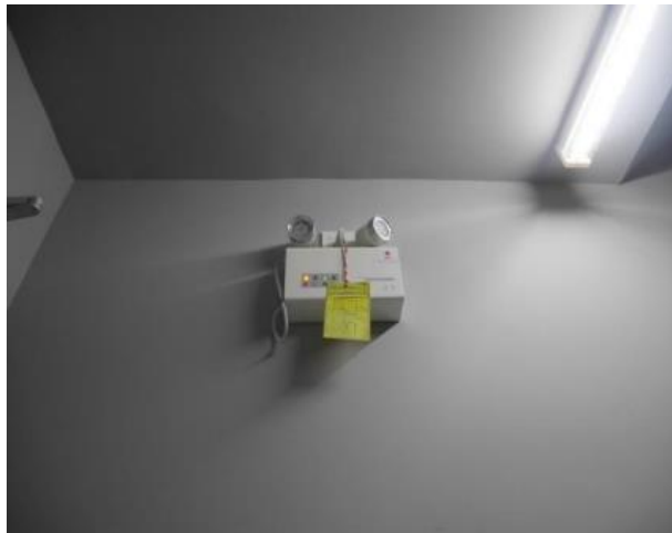
รูปที่ 3-34 ไฟฉุกเฉิน (Emergency Light)
