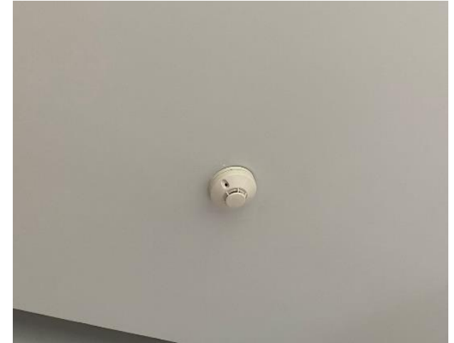
รูปที่ 3-32 เครื่องตรวจจับความร้อน (Heater Detective)
