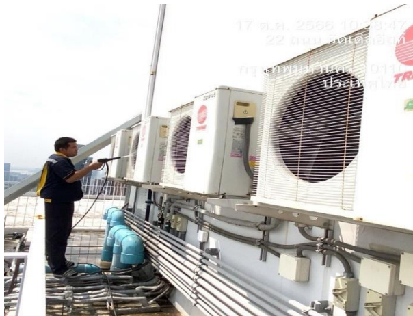
รูปที่ 3-29 ช่างอาคารทำความสะอาดเครื่องปรับอากาศส่วนกลาง
