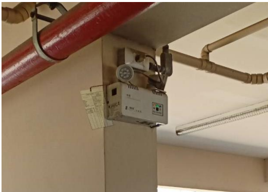
รูปที่ 3 ระบบไฟฟ้าฉุกเฉิน
