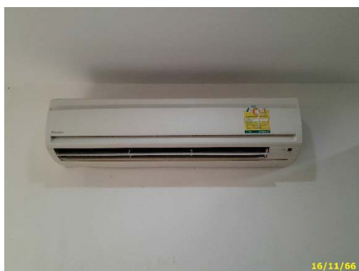
การระบายอากาศด้วยเครื่องปรับอากาศแบบแยกส่วน
