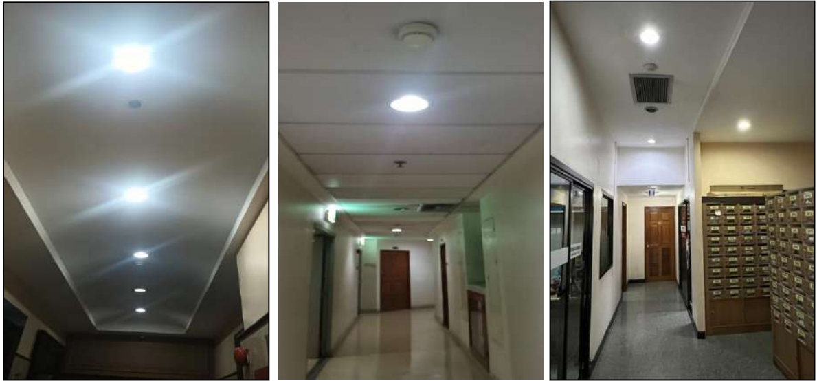
ภาพที่ 2-17 การเปลี่ยนมาใช้หลอดไฟ LED แทนหลอดตะเกียบ
