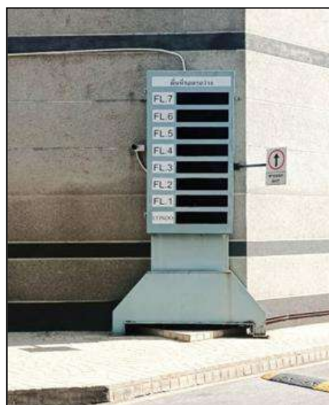
ภาพที่ 2-10 ระบบการตรวจนับช่องจอดรถในส่วนของ Plaza
