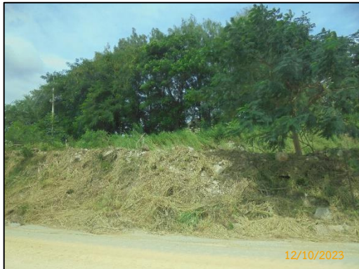
รูปที่ 2-18 แนวคันดินเพื่อควบคุมให้เศษหินที่ปลิวกระเด็นจากแรงระเบิดตกอยู่ในบริเวณพื้นที่ทำเหมือง
