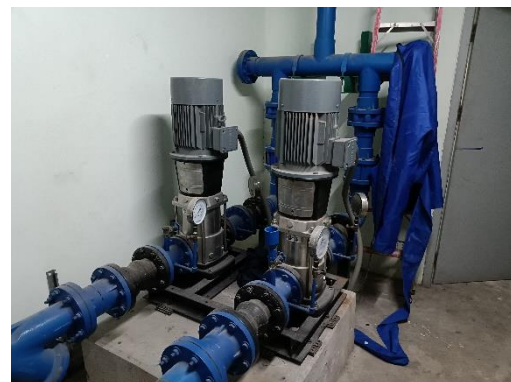
ปั๊มสูบน้ำขึ้นไปเก็บน้ำชั้นหลังคา
