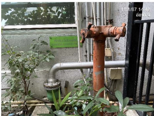
ภาพที่ 2-63 หัวรับน้ำดับเพลิงภายนอกอาคาร บริเวณด้านหน้าอาคารพักอาศัยและอาคารจอดรถ
