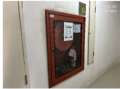
ภาพที่ 2-60 ตู้เก็บสายฉีดน้ำดับเพลิง
