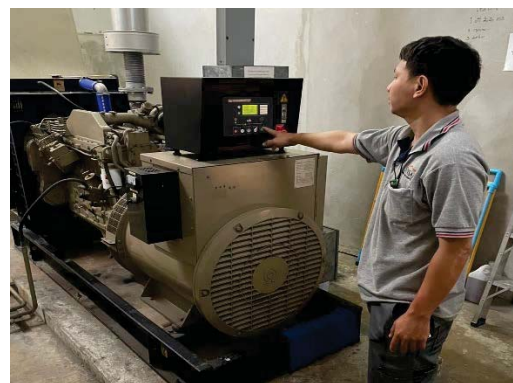
ดูแลตรวจสอบเครื่องไฟฟ้าสำรอง
