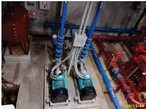
เครื่องสูบน้ำเพื่อการอุปโภค-บริโภค
