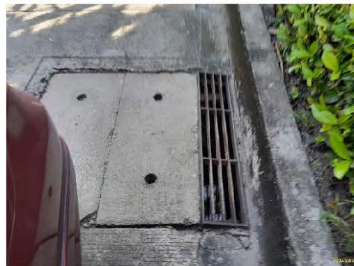
ตะแกรงดักขยะบริเวณฝาท่อระบายน้ำ
