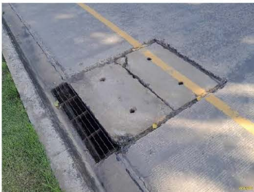
ตะแกรงดักขยะบริเวณฝาท่อระบายน้ำ
