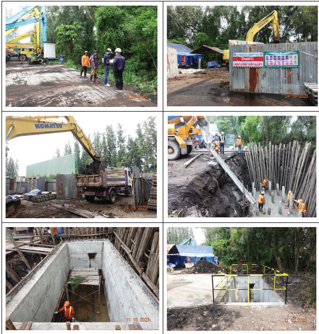
รูปที่ 1.5-3 : การก่อสร้างบ่อตกตะกอน
