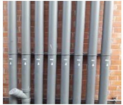
ท่อรวบรวมน้ำฝนและน้ำทิ้ง
