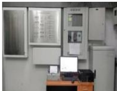
ตู้ควบคุมระบบFire Alarm
