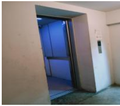
รูปที่ 35 ลิฟต์ดับเพลิง
