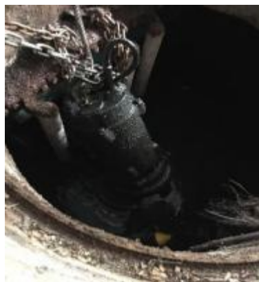
รูปที่ 20 เครื่องสูบน้ำที่ติดตั้งไว้ในบ่อหมุนวนน้ำ
