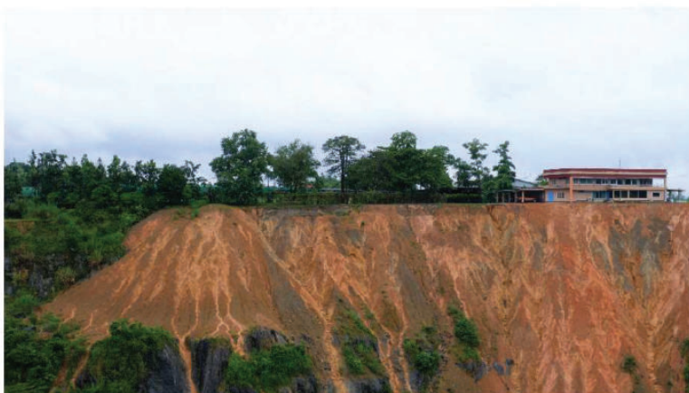
รูปที่ 10: การปรับถมดินบริเวณขอบบ่อเหมือง
