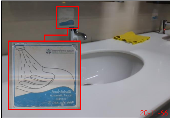
ติดตั้งก๊อกน้ำอัตโนมัติเพื่อช่วยประหยัดน้ำ
