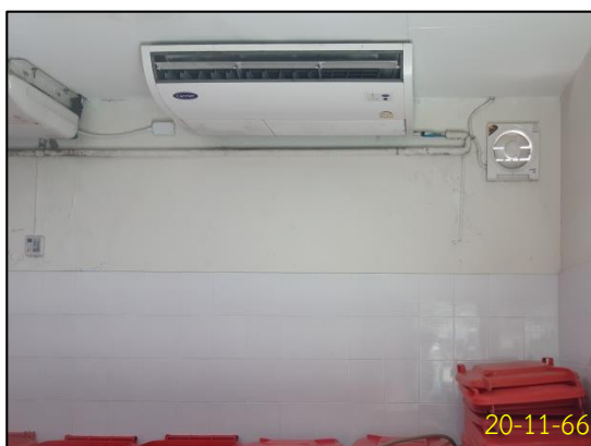
การปรับอุณหภูมิติดตั้งเครื่องปรับอากาศ ในห้องพักมูลฝอยติดเชื้อ
