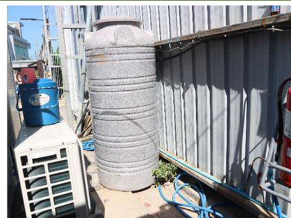
รูปที่ 2-26 ถังเก็บน้ำสำเร็จรูป
