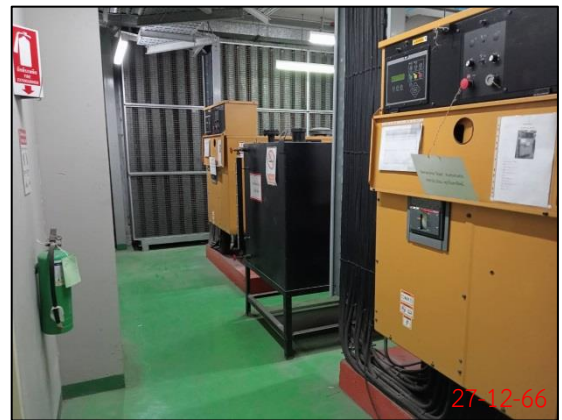
ติดตั้งถังดับเพลิงเคมีในเครื่องกำเนิดไฟฟ้าสำรอง
