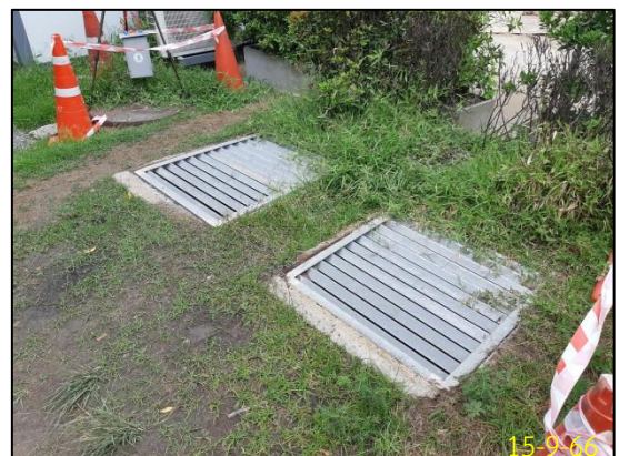
ตะแกรงดักมูลฝอยบริเวณบ่อบำบัด ก่อนเข้าสู่บ่อบำบัดน้ำ
