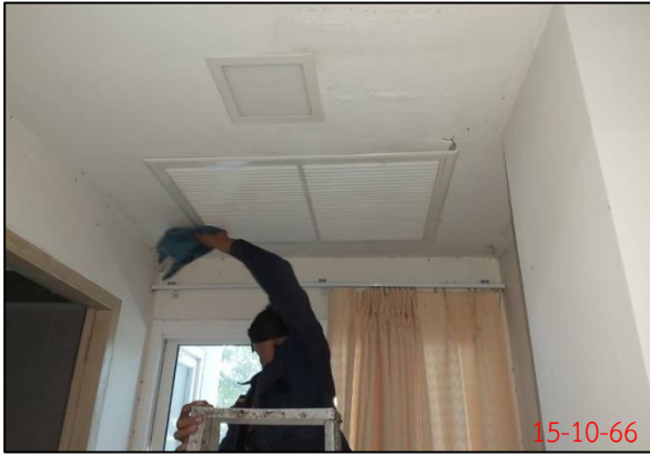
ล้างเครื่องปรับอากาศภายในอาคาร
