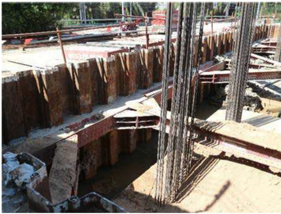
รูปที่ 2-1 Sheet Pile รอบบริเวณที่จะขุดดิน
