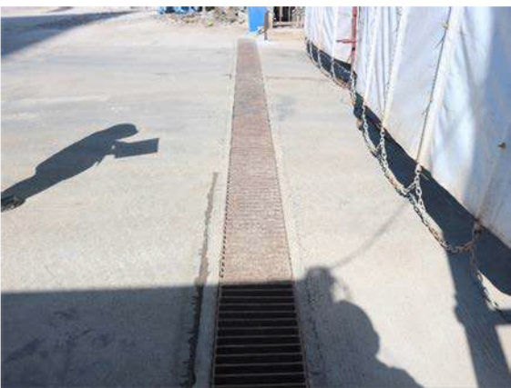
รูปที่ 2-4 ท่อและรางระบายน้ำของโครงการ
