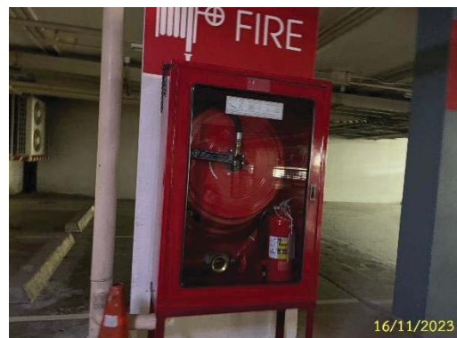
ตู้เก็บสายดับเพลิงและอุปกรณ์ประกอบ (FHC)
