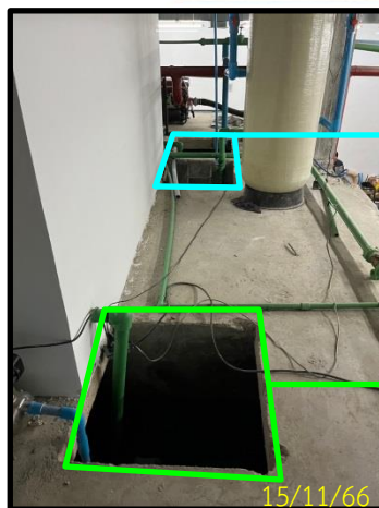
บ่อหน่วงน้ำชั้นใต้ดิน (ความจุ 57.23 ลบ.ม.) และถังเก็บน้ำใต้ดิน (ความจุ 137.09 ลบ.ม.)
