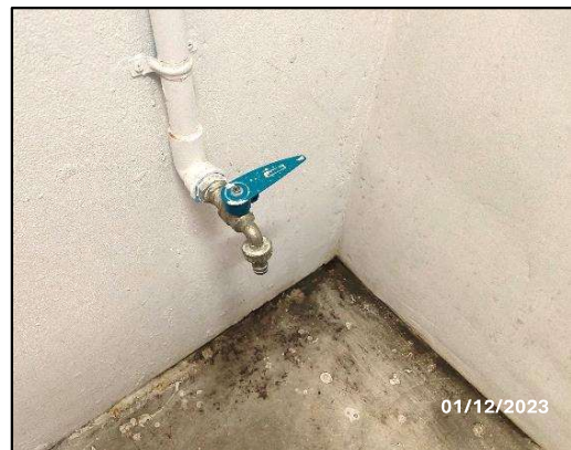
รูปที่ 19 ติดตั้งก๊อกน้ำและท่อระบายน้ำในห้องพักมูลฝอย
