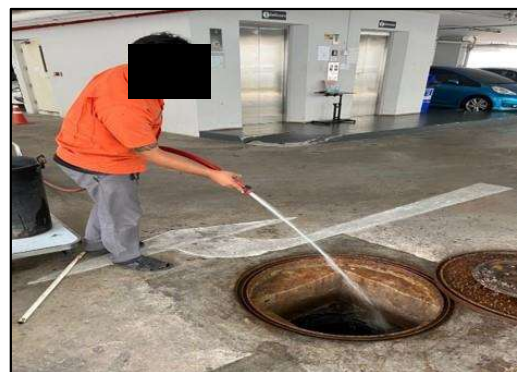
รูปที่ 29 ทำความสะอาด และตรวจสอบสิ่งอุดตันภายในท่อระบายน้ำและบ่อกักน้ำ
