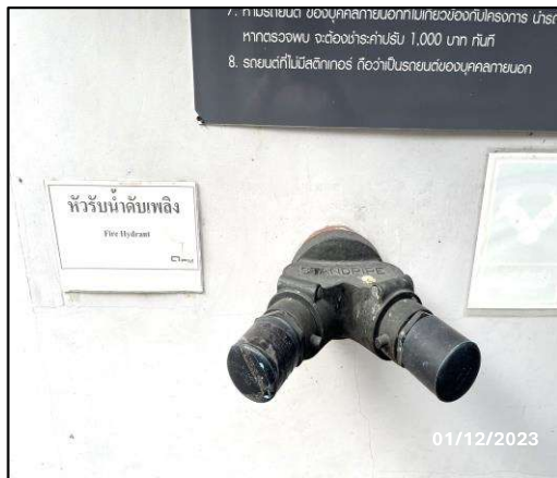
รูปที่ 36 ติดตั้งหัวรับน้ำดับเพลิงด้านหน้าโครงการ
