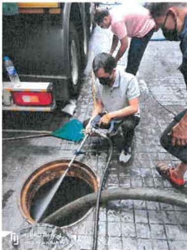
ภาพที่ 2.2-12 สุ่มตะกอน และตักไขมัน ระบบบำบัดน้ำเสีย
