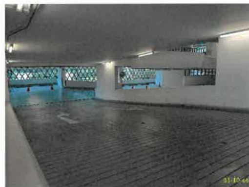
การระบายอากาศโดยวิธีธรรมชาติ ภาพที่ 1.3.10-1 ระบบระบายอากาศ
