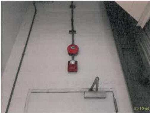
อุปกรณ์ส่งเสียง และแสงสัญญาณแจ้งเหตุ ระบบตรวจสอบและแจ้งเหตุเพลิงไหม้ (ต่อ)
