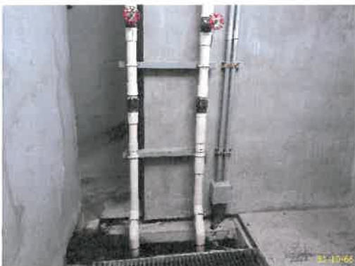
เครื่องสูบน้ำ และตู้ควบคุม ชั้นใต้ดิน ระบบระบายน้ำฝนภายในอาคาร ภาพที่ 2.2-5 การระบายน้ำโครงการ
