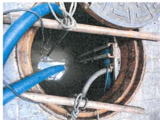
ภาพที่ 2.2-12 สุ่มตะกอน และตักไขมัน ระบบบำบัดน้ำเสีย
