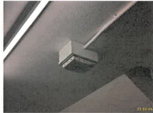
อุปกรณ์ส่งเสียง และแสงสัญญาณแจ้งเหตุ ระบบตรวจสอบและแจ้งเหตุเพลิงไหม้ (ต่อ)
