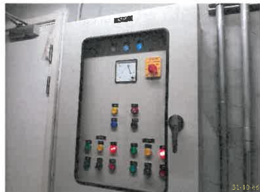
เครื่องสูบน้ำ และตู้ควบคุม ชั้นใต้ดิน ระบบระบายน้ำฝนภายในอาคาร ภาพที่ 2.2-5 การระบายน้ำโครงการ
