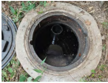
บ่อบำบัดน้ำก่อนเข้าสู่ระบบบำบัดน้ำเสียสำเร็จรูปของอาคารผู้โดยสารขาเข้า
