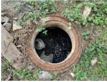
บ่อบำบัดน้ำเสียสำเร็จรูปของอาคารหอพักการบิน
