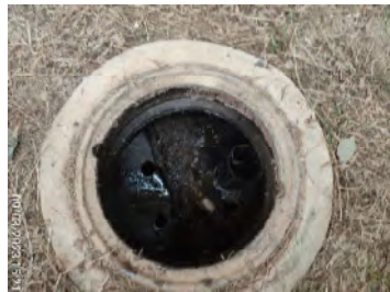
บ่อบำบัดน้ำก่อนเข้าสู่ระบบบำบัดน้ำเสียสำเร็จรูปของอาคารผู้โดยสารขาออก
