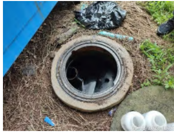
บ่อบำบัดน้ำหลังผ่านระบบบำบัดน้ำเสียสำเร็จรูปของอาคารผู้โดยสารขาเข้า
