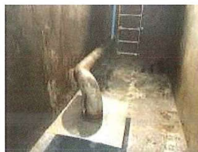
ภาพที่ 2.2-14 สิ่งทำความสะอาดถึงเก็บน้ำสำรองขึ้นใต้ดิน และชั้นดาดฟ้า
