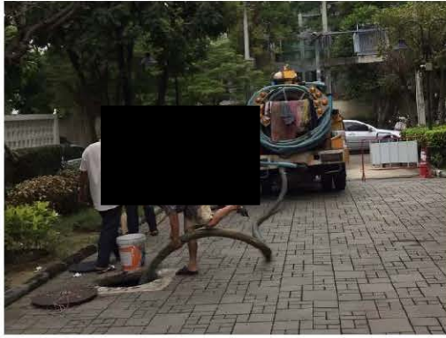
การสูบน้ำจากระบบบำบัด
