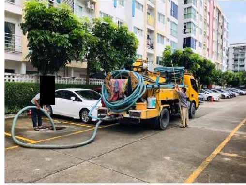
การสูบน้ำจากระบบบำบัด
