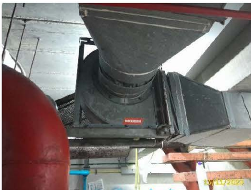
ระบบระบายอากาศด้วยวีลกล
