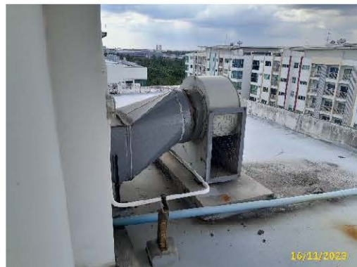
ระบบระบายอากาศด้วยวีลกล
