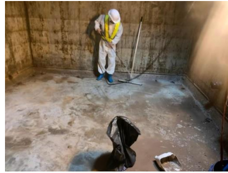
เจ้าหน้าที่ล้างถังเก็บน้ำสำรองน้ำใช้
