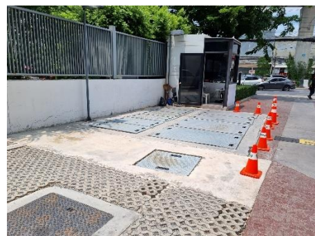
บ่อหน่วงน้ำก่อนระบายออก
