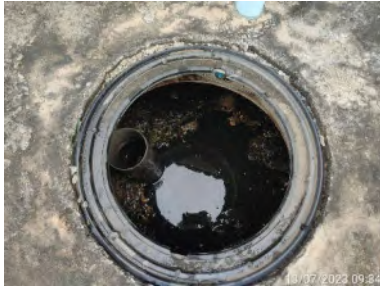
บ่อบำบัดน้ำก่อนผ่านระบบบำบัดน้ำเสียอาคารที่พักผู้โดยสาร
