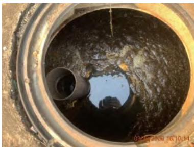
บ่อกักน้ำก่อนผ่านระบบบำบัดน้ำเสียอาคารที่พักผู้โดยสาร
