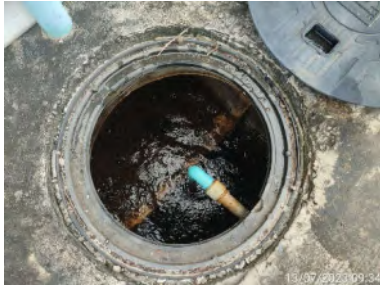
บ่อบำบัดน้ำหลังผ่านระบบบำบัดน้ำเสียอาคารที่พักผู้โดยสาร
