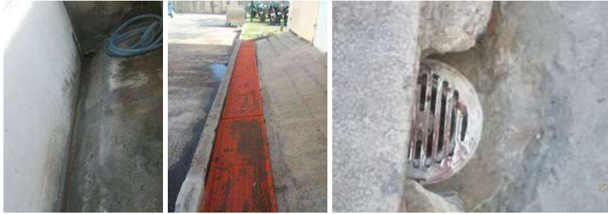
ภาพที่ 6-H สภาพเพื่อระบายน้ำรอบห้องพัชยะ ซึ่งน้ำที่เกิดขึ้นมีการระบายลงสู่ระบบบำบัดน้ำเสียของโรงพยาบาล
