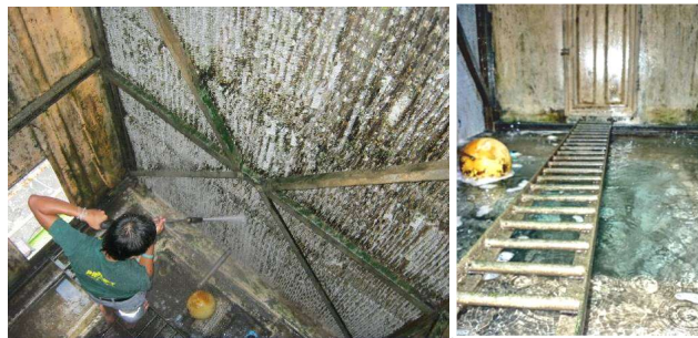
ภาพที่ 10-C การล้างทำความสะอาดถังรับน้ำระบบระบายอากาศ
