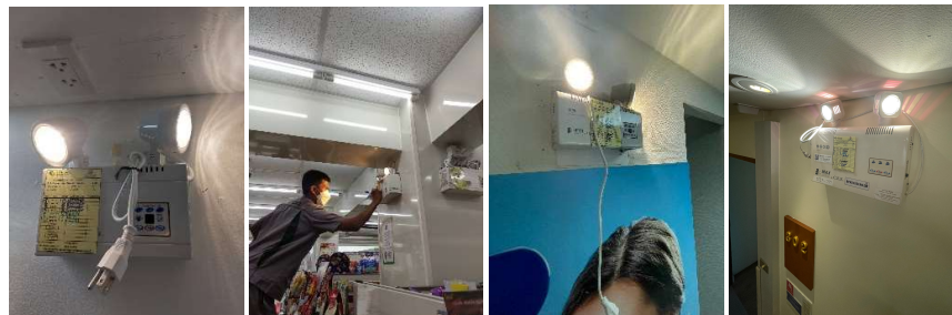
รูปที่ 28 การตรวจสอบสภาพความพร้อมใช้ของระบบไฟฉุกเฉิน ในโรงพยาบาล
