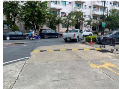
ภาพที่ 1-B ติดตั้งสั่นนูนเพื่อลดความเร็ว
