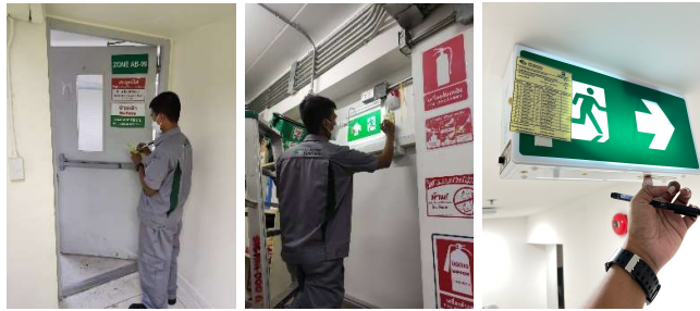
รูปที่ 26 การตรวจสอบอุปกรณ์ระบบทางหนีไฟ ป้ายทางหนี และประตุนีไฟในโรงพยาบาล
