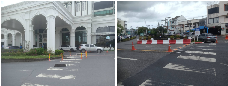
ภาพที่ 11-B ติดตั้งเสาจราจรบริเวณทางม้าลายของวงเวียนหน้าอาคาร เพื่อลดความเสี่ยงของการเกิดอุบัติเหตุจราจร และเพิ่มจุดติดตั้งเนินชะลอความเร็ว
