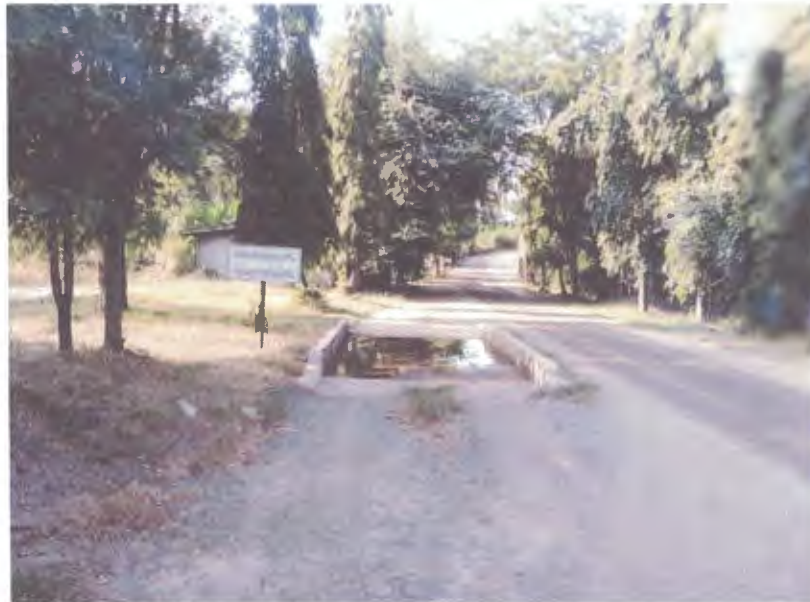
รูปที่ 17 แสดงบ่อล้างล้อก่อนขนแร่ออกจากพื้นที่โรงโม่
