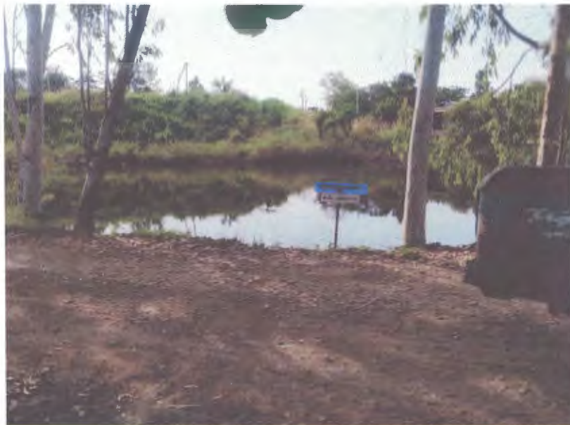
รูปที่ 15 บ่อคัดตะกอน ด้านตะวันออกของโรงโม่หินใช้รองรับปริมาณน้ำขุนชั้นที่ชะล้างผ่านที่เก็บกองเปลือกดิน และบริเวณหน้าเหมือง
