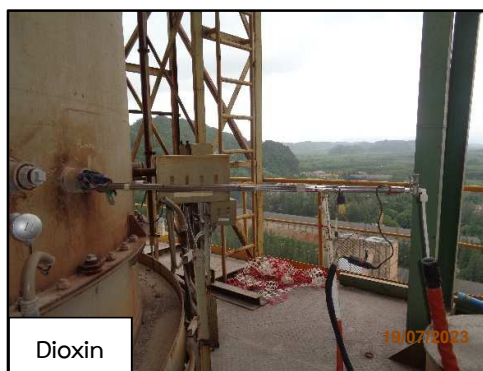
ภาพที่ 3.4 (ต่อ) การตรวจวัดคุณภาพอากาศจากปล่องหม้อเผา 6
