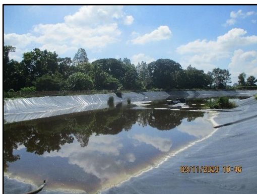
ภาพที่ 2.21 บ่อพักน้ำทิ้ง (Retention Pond) ขนาดความจุ 30,400 ลูกบาศก์เมตร
