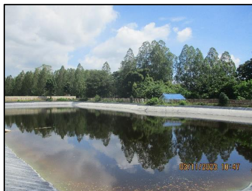
ภาพที่ 2.22 บ่อพักน้ำฉุกเฉิน (Emergency Pond) ขนาดความจุ 15,200 ลูกบาศก์เมตร
