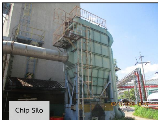
ภาพที่ 2.4 การติดตั้งระบบดักฝุ่นแบบถุงกรอง (Bag Filter) ควบคุมบริเวณ Chip Silo และ Chip Screen
