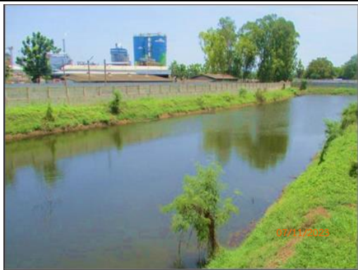
ภาพที่ 2.19 บ่อหน่วงน้ำฝน ขนาดความจุ 40,000 ลูกบาศก์เมตร ภายในพื้นที่โครงการ
