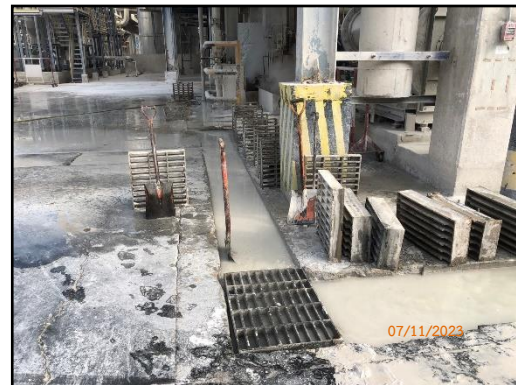
ภาพที่ 2.38 การขุดลอกรางระบายน้ำฝน
