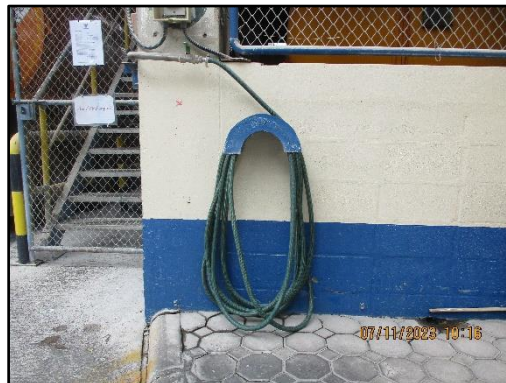
ภาพที่ 2.32 สายน้ำแรงดันสูงสำหรับการล้างล้อรถก่อนปล่อยออกนอกพื้นที่โครงการ เพื่อป้องกันการฟุ้ง กระจายของเศษหินปูนออกสู่ภายนอกโครงการ
