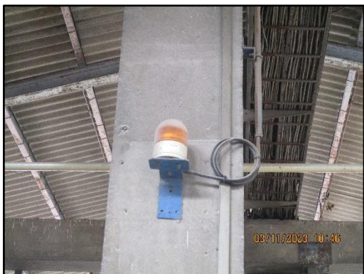
ภาพที่ 2.57 การติดตั้งเครื่องวัดความเข้มข้นคลอรีนในอากาศ (Chlorine Gas Detector) บริเวณต่างๆ และสัญญาณแจ้งกรณีที่เกิดคลอรีนรั่วไหล
