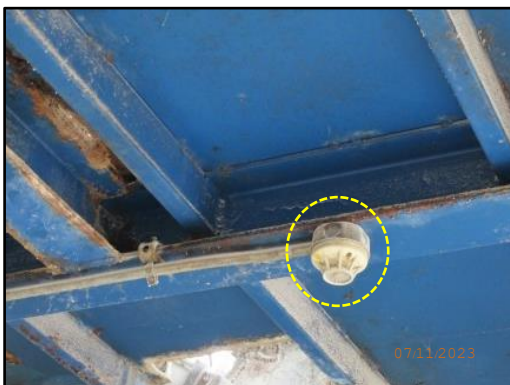
ภาพที่ 2.64 เครื่องตรวจจับก๊าซเชื้อเพลิงซีมวล (Flammable Gas Detector) บริเวณใกล้เคียงกับอุปกรณ์ที่ เกี่ยวข้องกับก๊าซเชื้อเพลิงซีมวล
