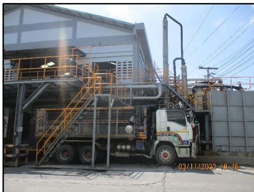
ภาพที่ 2.35 รถบรรทุกรับกากตะกอนจากระบบ บำบัดน้ำเสียไปใช้เป็นเชื้อเพลิงใน หม้อต้มไอน้ำให้กำลัง (Power Boiler)
