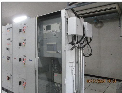
ภาพที่ 2.7 จอแสดงผล (Monitor) และชุดควบคุมอุปกรณ์ตรวจวัดมลสารที่ระบายออกจากปล่องอย่างต่อเนื่อง (Continuous Emission Monitoring System : CEMS)
