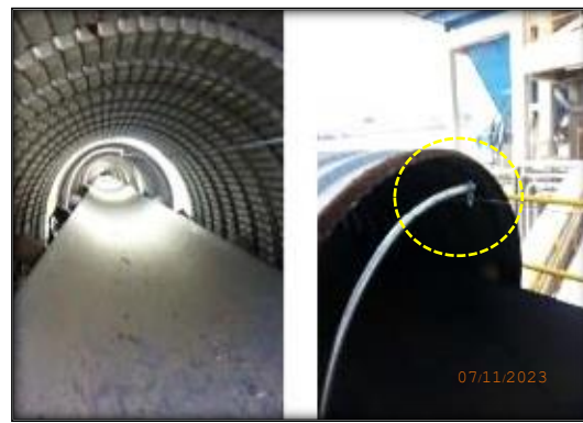
ภาพที่ 2.65 เครื่องตรวจจับความร้อน (Heat Detector) บริเวณใกล้เคียงกับ อุปกรณ์ที่เกี่ยวข้องกับก๊าซเชื้อเพลิง ซีมวล
