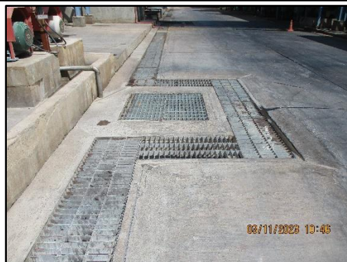
ภาพที่ 2.20 ระบบรวบรวมน้ำภายในพื้นที่โครงการ (แยกน้ำฝนและน้ำเสีย)
