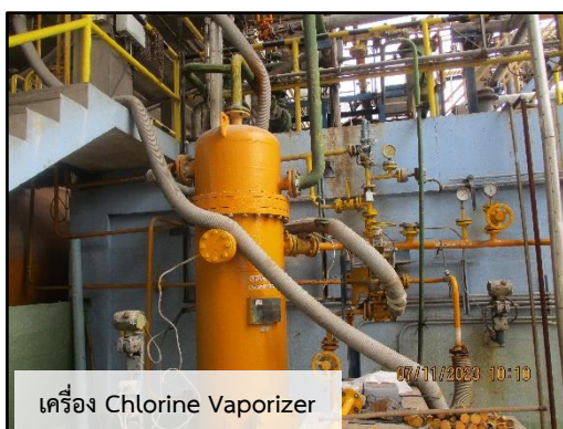
ภาพที่ 2.55 สภาพอุปกรณ์ต่างๆ และท่อภายในบริเวณถังเก็บคลอรีนเหลว
