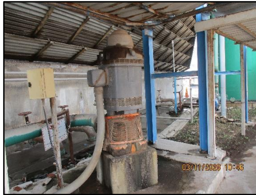
ภาพที่ 2.33 เครื่องสูบน้ำสำหรับสูบน้ำบาดาลของโครงการ
