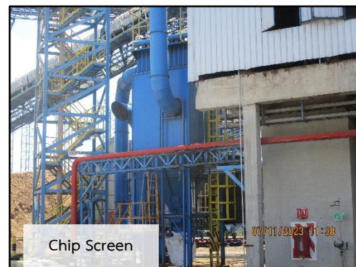
ภาพที่ 2.4 การติดตั้งระบบดักฝุ่นแบบถุงกรอง (Bag Filter) ควบคุมบริเวณ Chip Silo และ Chip Screen
