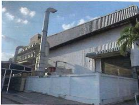
ภาพที่ 1 ระบบดักฝุ่นแบบถุงกรองฝุ่น (Bag house Stack)
