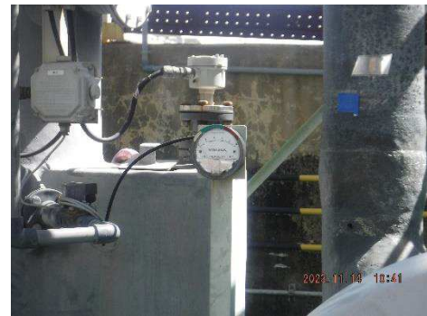
ภาพที่ 2.2-18 Pressure Gauge บ่อ Surge II
