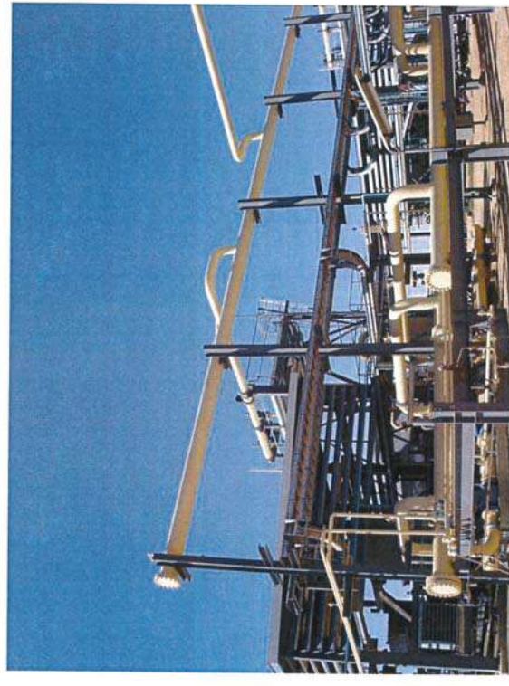
รูปที่ 2-12 ตัวอย่าง Flare Header
