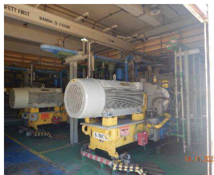
ภาพที่ 2.2-44 เครื่องสูบน้ำดับเพลิง
