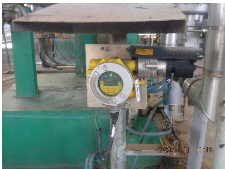
ภาพที่ 2.2-39 Gas Detector บริเวณกระบวนการผลิต
