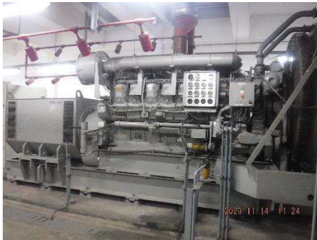
ภาพที่ 2.2-21 เครื่องกำเนิดไฟฟ้าสำรอง (Emergency Generator)
