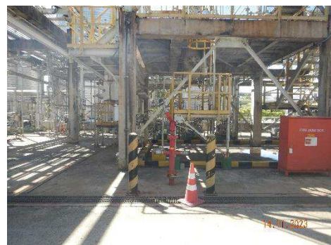
ภาพที่ 2.2-53 Water Hydrant บริเวณกระบวนการผลิต
