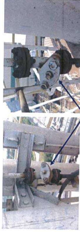
รูปที่ 4-6 ตัวอย่าง Pilot Gas Strainer
