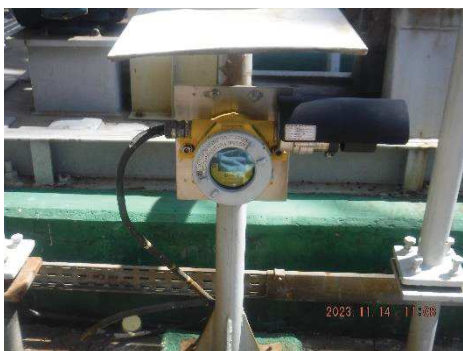
ภาพที่ 2.2-58 Gas Detector บริเวณถังเก็บกัก
