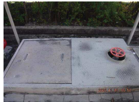
ภาพที่ 2.2-30 บ่อ (Sump) รวบรวมสารเคมี ที่อาจหกรั่วไหล
