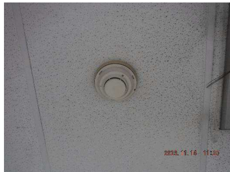
ภาพที่ 2.2-40 Smoke Detector บริเวณอาคารต่างๆ
