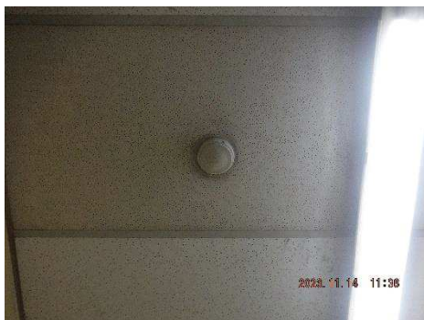
ภาพที่ 2.2-41 Heat Detector บริเวณอาคารต่างๆ
