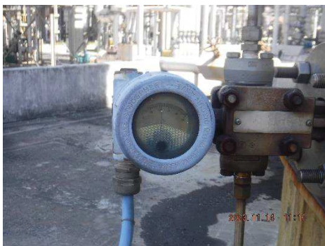
ภาพที่ 2.2-56 Level Indicator บริเวณถังเก็บกัก
