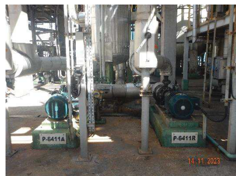
ภาพที่ 2.2-9 Double Mechanical Seal Pump
