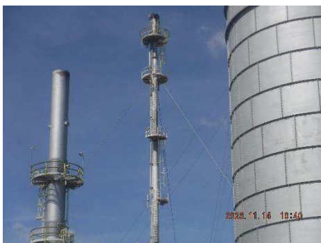
ภาพที่ 2.2-4 หอเผาที่ระดับเหนือพื้นดิน (Elevated Flare)
