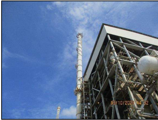
รูปที่ 2-16 ระบบควบคุมมลพิษทางอากาศ (Recovery Boiler Stack)
