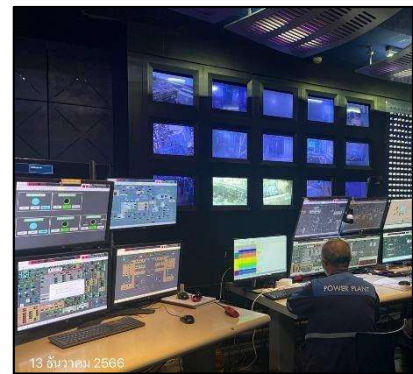
รูปที่ 2-24 ห้องควบคุมการผลิต/พนักงานปฏิบัติงาน ในห้องปรับอากาศ
