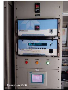
รูปที่ 2-4 เครื่องมือตรวจวัดคุณภาพอากาศอย่างต่อเนื่อง ที่ปล่อง Recovery Boiler
