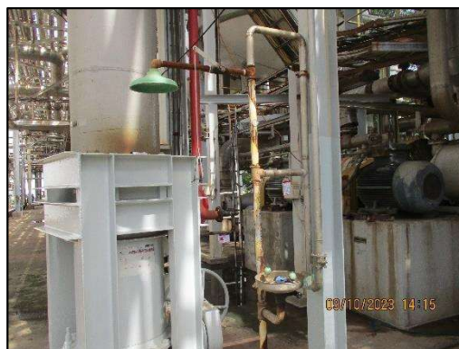
รูปที่ 2-30 ฝักบัวและอ่างล้างตาฉุกเฉินบริเวณถังสารเคมี
