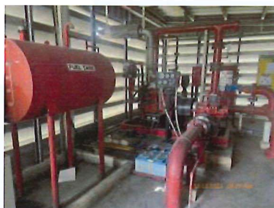
ภาพที่ 50 ชุดเครื่องสูบน้ำดับเพลิง
