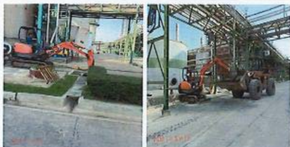
ภาพที่ 8 การขุดลอกร่องระบายน้ำฝน
