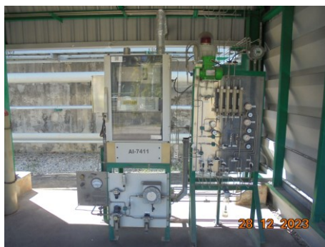
ภาพที่ 2.2-7 Gas Analyzer
