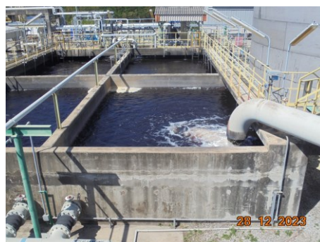
ภาพที่ 2.2-15 ระบบบำบัดน้ำเสียของสายการผลิตที่ 1 และ 2
