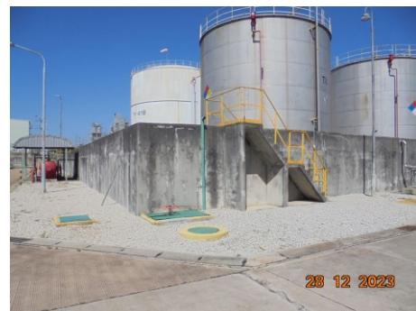
ภาพที่ 2.2-54 กำแพงกันสารเคมี เพื่อป้องกันสารเคมีหกรั่วไหล
