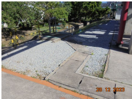
ภาพที่ 2.2-24 รางระบายน้ำฝนที่เชื่อมต่อ กับรางระบายน้ำฝนของนิคมฯ
