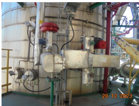
ภาพที่ 2.2-53 Shut Down Valve และ Safety Valve
