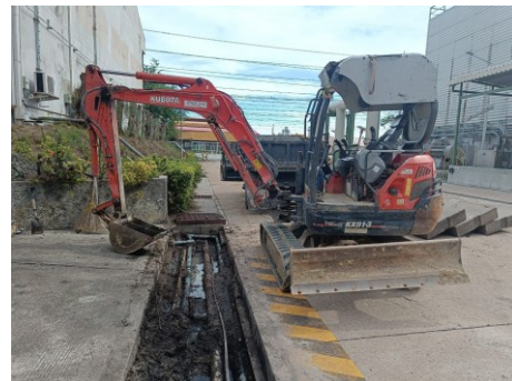
ภาพที่ 2.2-25 การขุดลอกรางระบายน้ำฝน
