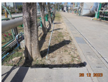
ภาพที่ 2.2-19 ท่อส่งน้ำทิ้งหลังผ่านการบำบัดนำมารดน้ำต้นไม้
