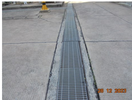
ภาพที่ 2.2-26 รางระบายน้ำฝนปนเปื้อนภายในโรงงาน
