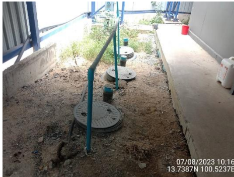
ภาพที่ 2.2-19 ถังบำบัดน้ำเสียสำเร็จรูป
