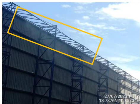
ภาพที่ 2.2-12 ม่านละอองน้ำบริเวณรั้ว Metal Sheet
