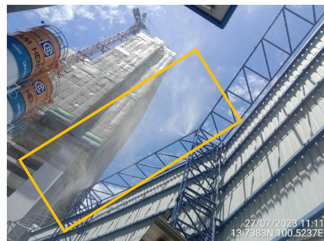
ภาพที่ 2.2-12 ม่านละอองน้ำบริเวณรั้ว Metal Sheet
