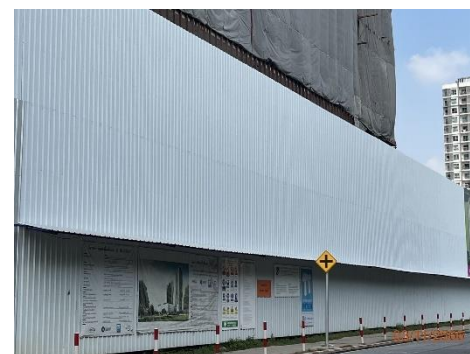
ภาพที่ 2.2-2 แนวรั้วทึบ (Metal Sheet) บริเวณอาคารศาลเจ้าฯ
