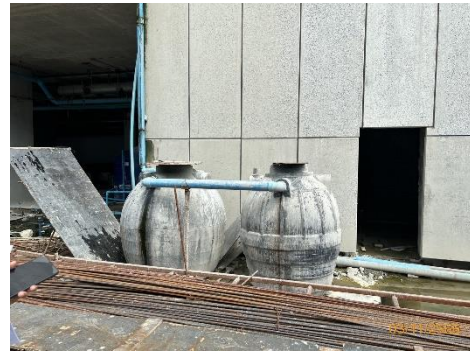
ภาพที่ 2.2-19 ถังบำบัดน้ำเสียสำเร็จรูป
