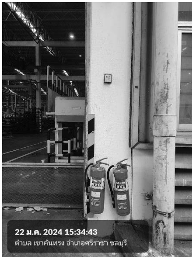
ภาพที่ 2 ถังดับเพลิงแบบมือถือ
