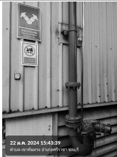
ภาพที่ 42 เครื่องสูบน้ำดับเพลิงและหัวรับน้ำดับเพลิง
