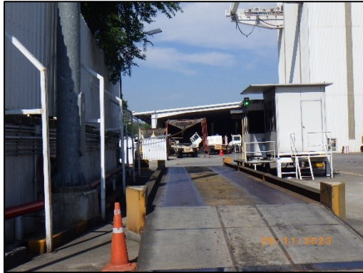
รูปที่ 2-31 เครื่องชั่งน้ำหนัก
