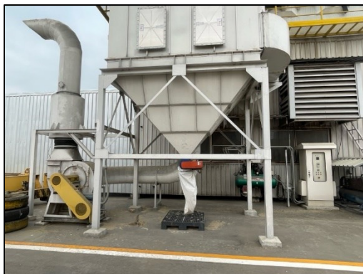
รูปที่ 2-14 อุปกรณ์ดักจับฝุ่น (Bag Filter)
