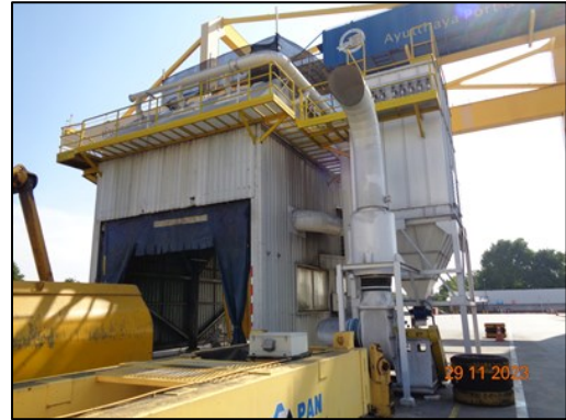
รูปที่ 2-13 เครื่องดักจับฝุ่น (Bag Filter)
