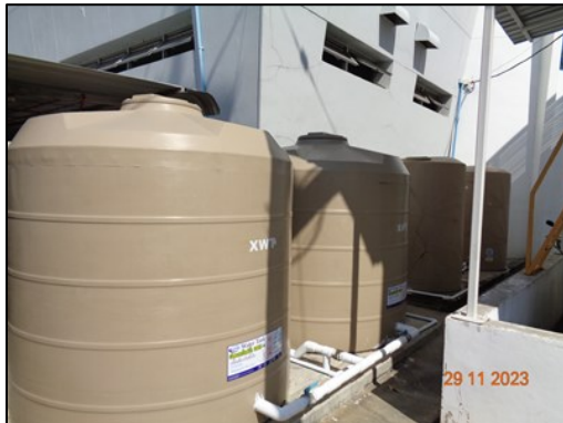
รูปที่ 2-40 ถังเก็บน้ำชนิดวางบนดิน
