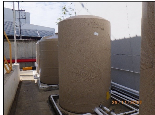
รูปที่ 2-40 ถังเก็บน้ำชนิดวางบนดิน
