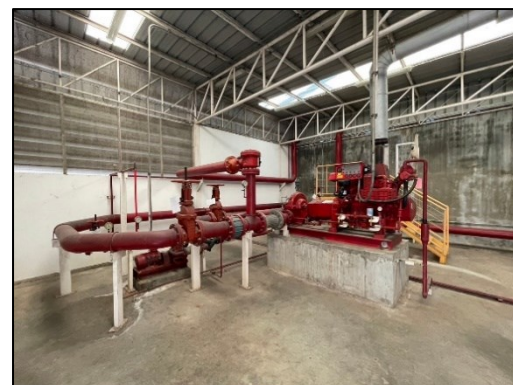
รูปที่ 2-55 เครื่องสูบน้ำดับเพลิง (Fire Pump)
