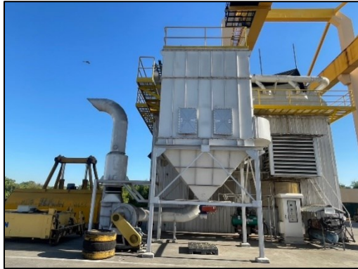
รูปที่ 2-13 เครื่องดักจับฝุ่น (Bag Filter)
