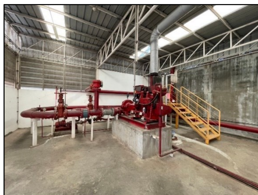
รูปที่ 2-55 เครื่องสูบน้ำดับเพลิง (Fire Pump)
