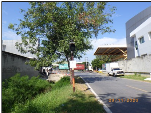
รูปที่ 2-36 การติดตั้งไฟสัญญาณและเครื่องหมายแสดงขอบเขตพื้นที่โครงการ
