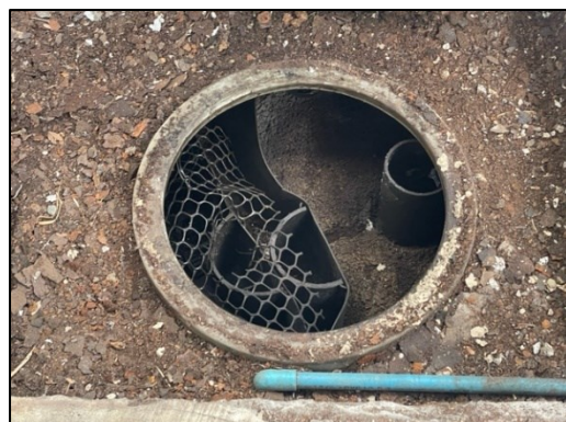
รูปที่ 2-46 บ่อดักจับคราบไขมันและน้ำมัน (Oil Separator)
