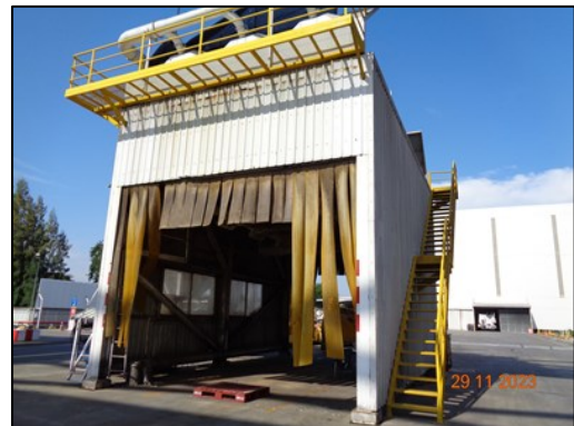
รูปที่ 2-21 ขนถ่ายสินค้าผ่าน HOPPER
