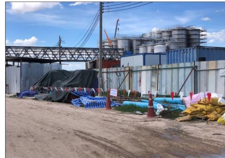
รูปที่ 5 การปิดคลุมกองวัสดุก่อสร้าง
