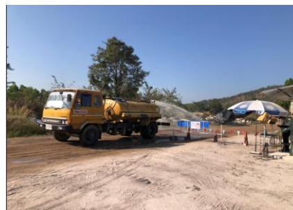
รูปที่ 6 การฉีดพรมน้ำในพื้นที่ก่อสร้าง
