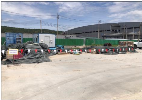
รูปที่ 5 การปิดคลุมกองวัสดุก่อสร้าง
