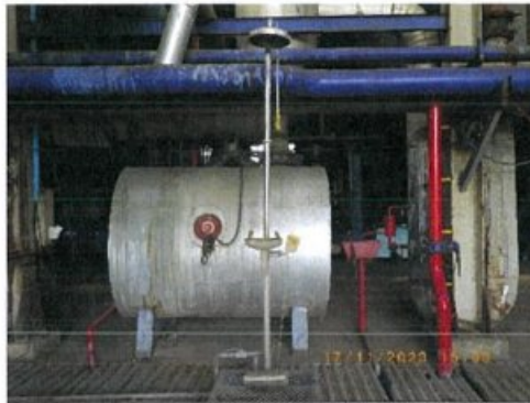
ภาพที่ 57 จัดให้มีฝักบัวฉุกเฉิน และอ่างล้างตา
