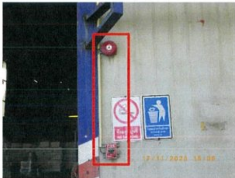
ภาพที่ 72 การติดตั้งสัญญาณแจ้งเหตุเพลิงไหม้
