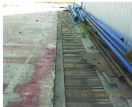
ภาพที่ 14 รางระบายน้ำเสียจากการล้างพื้นและอุปกรณ์เครื่องจักรของโครงการ
