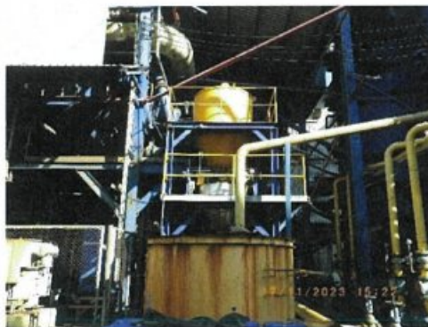
ภาพที่ 71 การติดตั้งปั๊มดูดเก็บเข้าถังเก็บกากน้ำตาล
