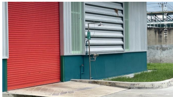
รูปที่ 41 ฝักบัวล้างตาฉุกเฉิน
