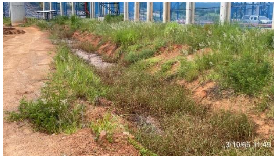
รูปที่ 14 รางระบายน้ำรอบลานเก็บกองกากอ้อย
